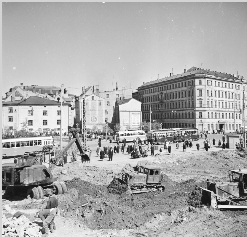
13.janvāra ielas pārbūves darbi pēc autoostas nojaukšanas. 1959.gada 13.maijs. LNA LVKFFDA 1.f., 2273-1.
